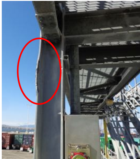
Bent column Flange
